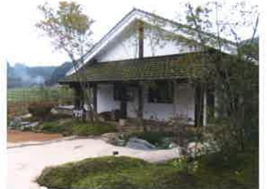
北面外壁(防カビ・防コケ)
